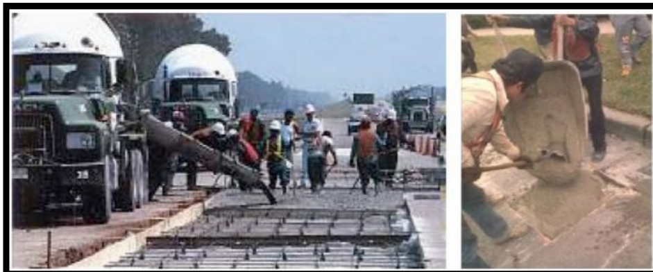
Figura 7 – Uso do geopolímero Pyrament, nos Estados Unidos, como material de reparação de rodovias.
