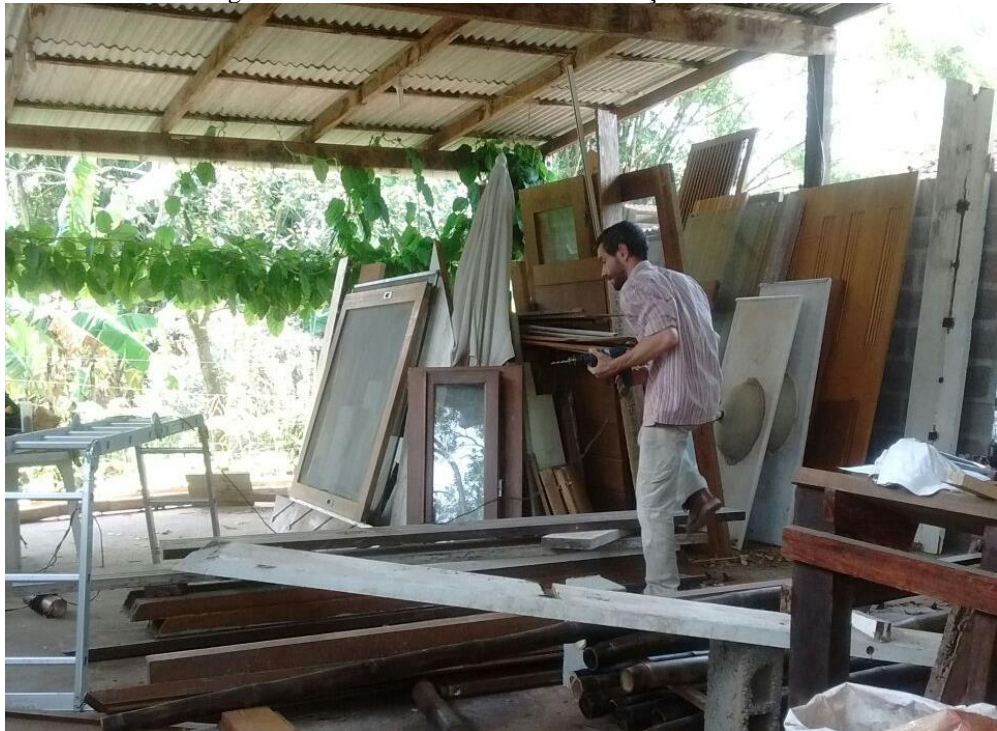
Figura 11 - Reuso de materiais de demolição
