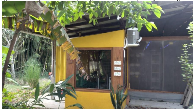
Figura 16 - Galpão reformado, abrigando as salas da produção de cogumelos
