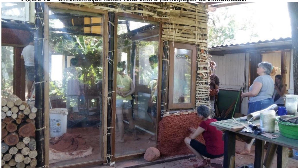
Figura 12 – Bioconstrução sendo feita com a participação da comunidade.
