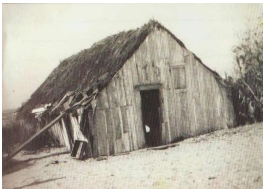
Figura 14: (Des)continuidades – Habitação em barrão e madeira. Fonte: acervo AMIC.
