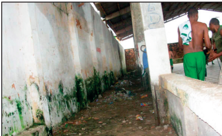
Foto 2 – Espaço lateral da quadra de esporte do bairro do Anjo da Guarda.
