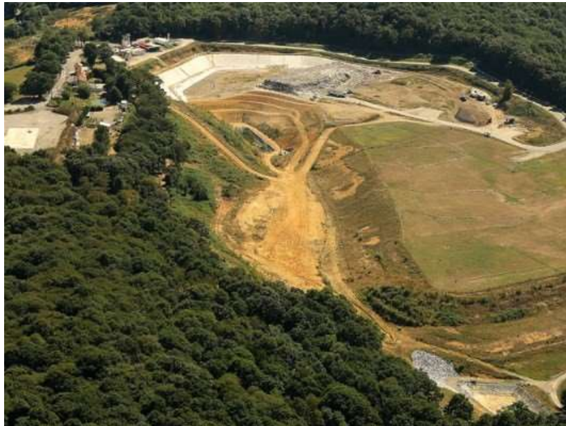
Figura 4 – Aterro Sanitário de Bénac
