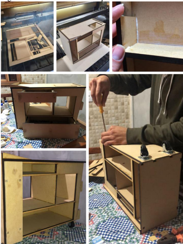
Figura 58 – Processo de construção do modelo escala 1:3 etapa I
