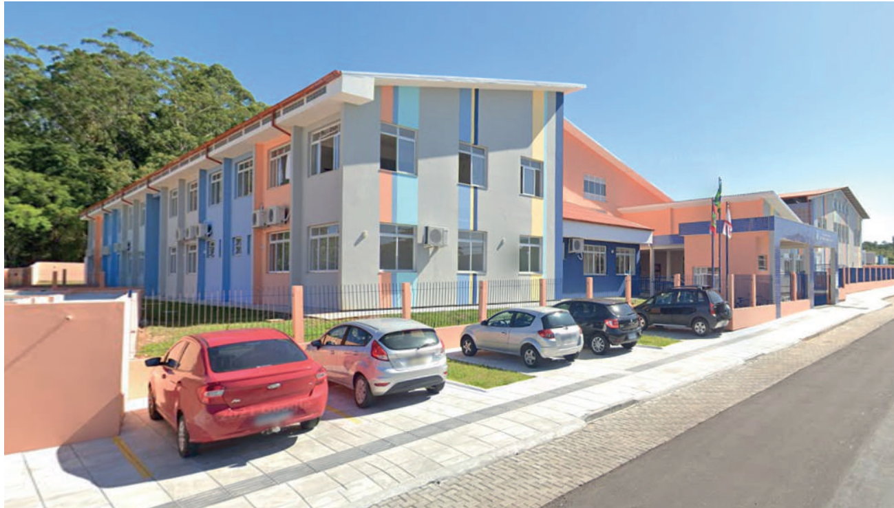
Figuras 21: Escola Municipal no entorno próximo a área de intervenção. Fonte: Autora, 2021.
