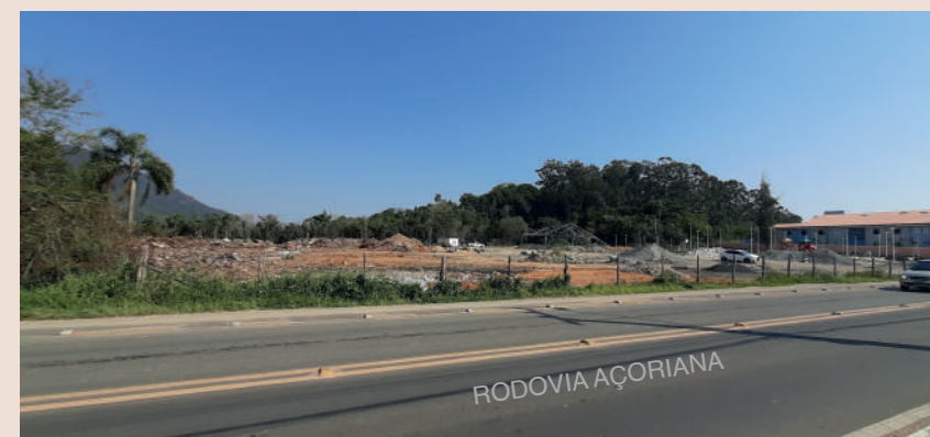
Figura 16: Frente da área de intervenção. Lote sendo utilizado como local para despejo de construção. Fonte: Autora, 2021.
