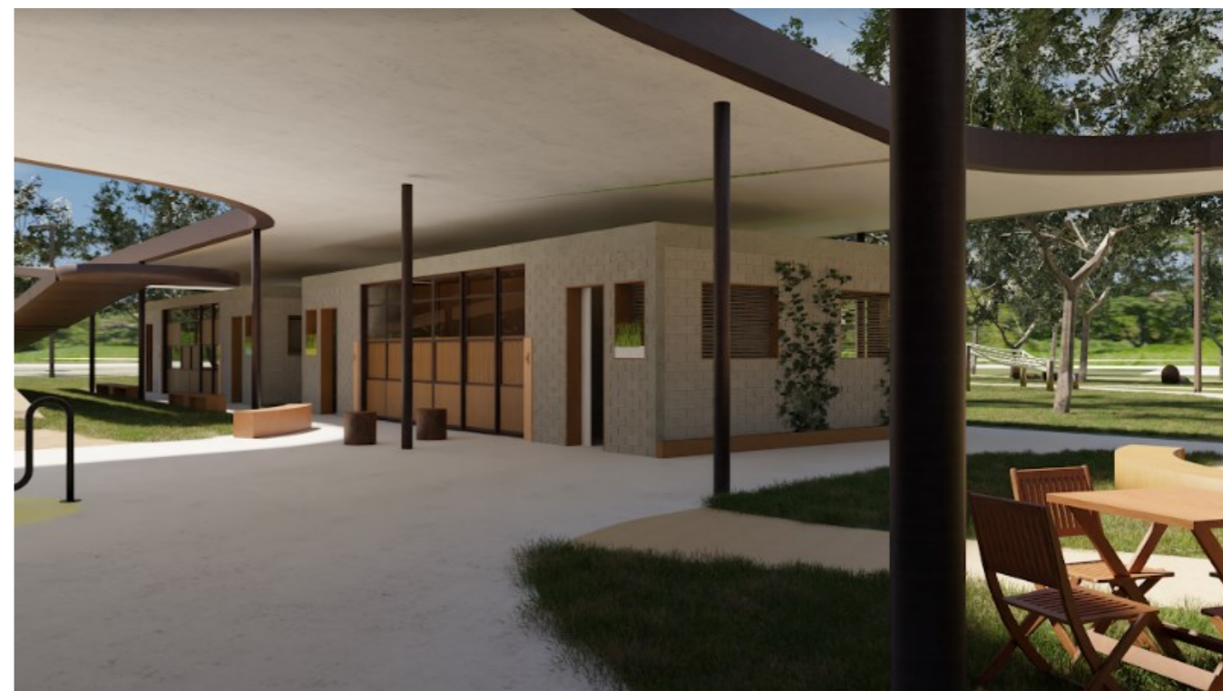
Módulos com esquadrias de correr todas fechadas, com lajes e cobertura
