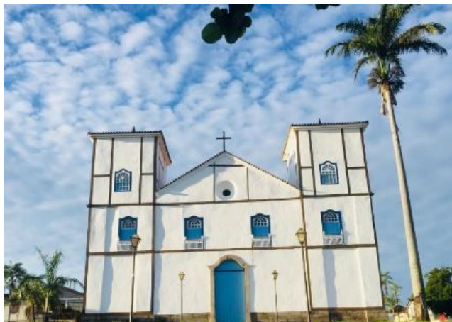
Figura 25 - Vista frontal da Igreja Matriz de Pirenópolis
