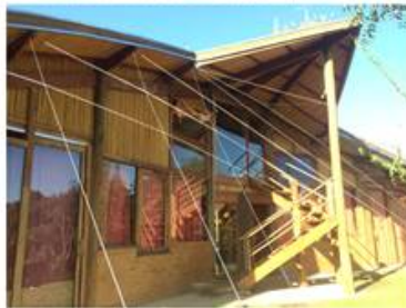
Figura 3. (a) Parede de blocos de solo-cimento; (b) Blocos de solo-cimento, janelas e estruturas de bambu; (c) Parede monolítica de terra e cal. Fonte: acervo Ecovila Bambu.
