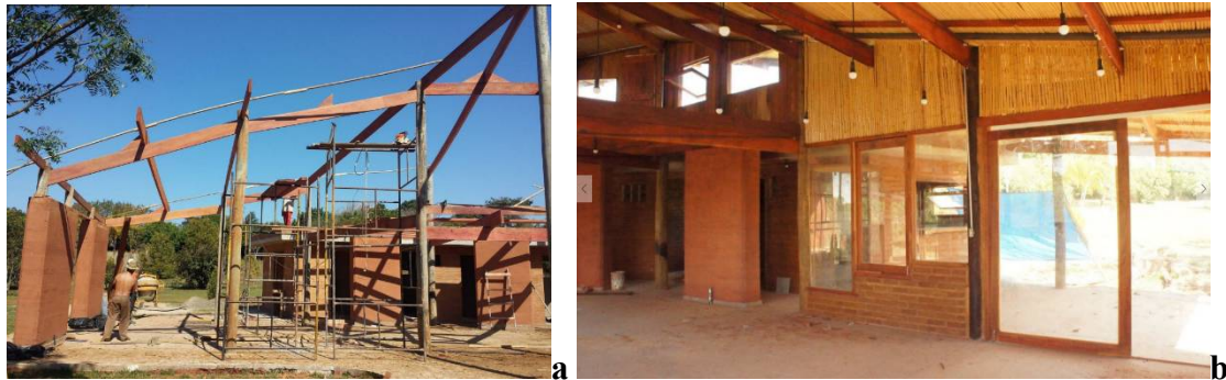
Figura 4 (a) Montagem da estrutura do telhado. (b) Detalhe dos materiais utilizados. Fontes: acervo Ecovila Bambu e autores.
