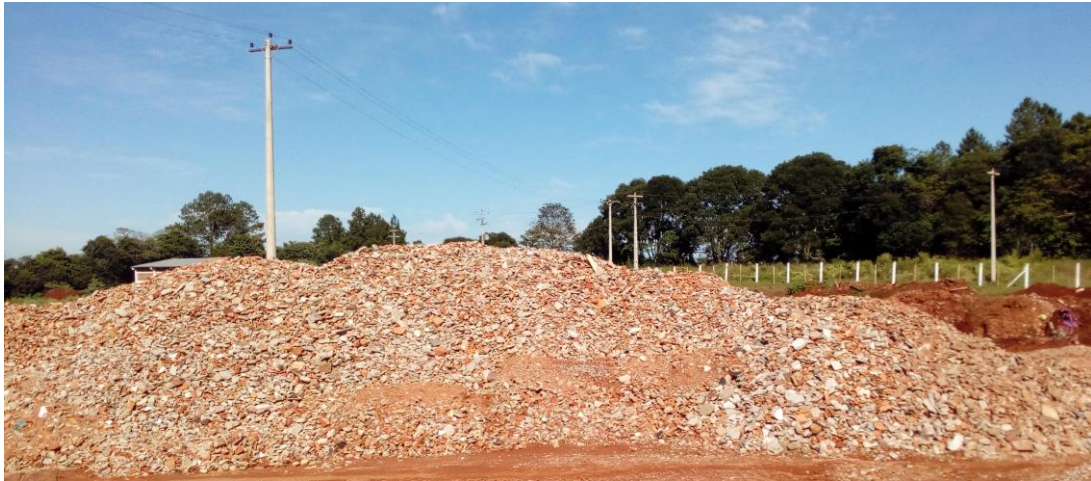
Figura 3: Resíduo recolhido da obra. Fonte: próprio autor (2016).
