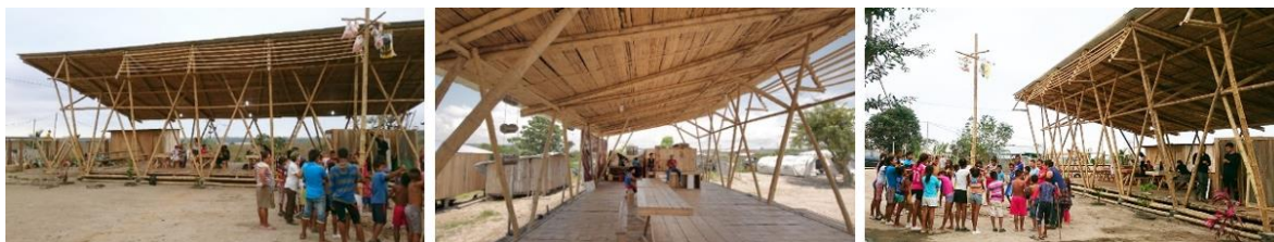
Figura 1: Moradores na fachada principal e no interior da edificação. Fonte: RAMA ESTUDIO, 2016
