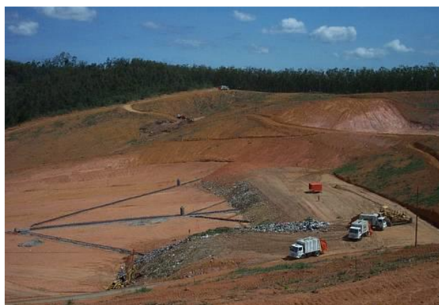
Figura 2: Aterro sanitário em Santana do Paraíso. Fonte: SCS ENGINEERS, 2011.
