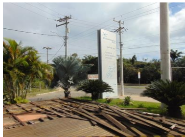
Figura 24: Abandono do Centro de Monitoramento e Pesquisa. Fonte: Autores, 2017.
