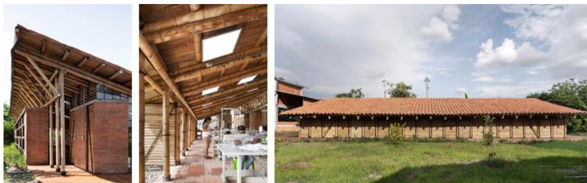
Figura 3: Área de trabalho e fachadas. Fonte: ARCHDAILY BRASIL, 2020
