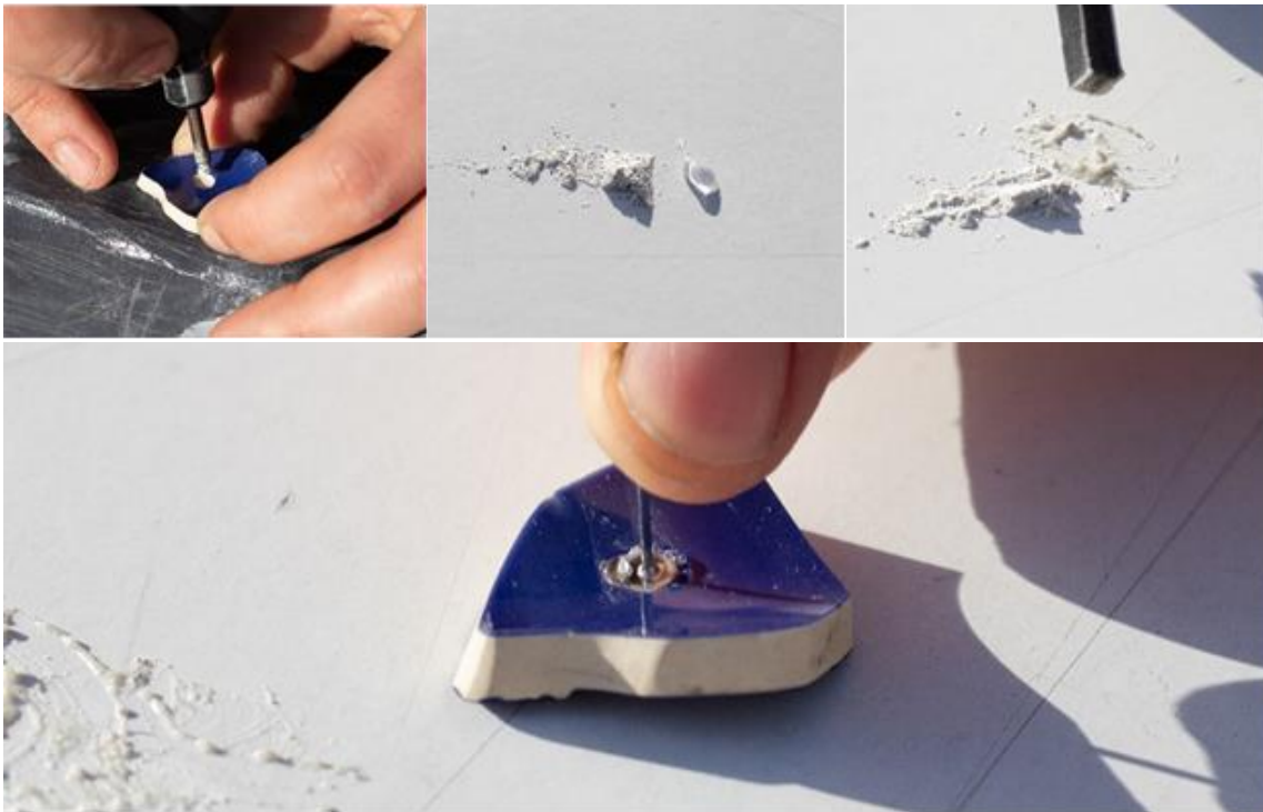
Figura 8 – Solução de fixação dos acessórios metálicos à Cerâmica. Em cima à esquerda: furação de cavidade para encaixe; em cima ao centro pó cerâmico e cola gel; em cima à direita: mistura de pó com cola; em baixo: encaixe e colagem.
