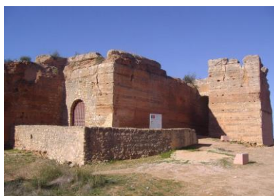
Figura 6: construção militar em taipa, castelo de Paderne, Algarve. Fonte: Beechgrove.
