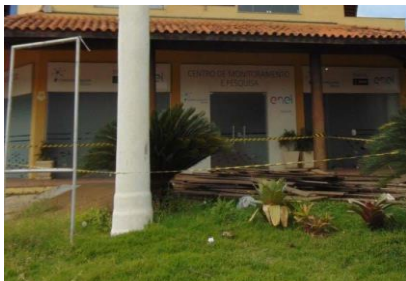
Figura 23: Abandono do Centro de Monitoramento e Pesquisa. Fonte: Autores, 2017.
