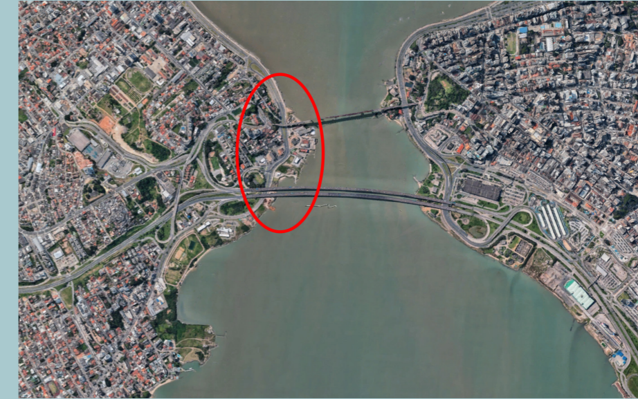
Espaço de ancoragem das cabeceiras das pontes Fonte: Google Earth – 2022
