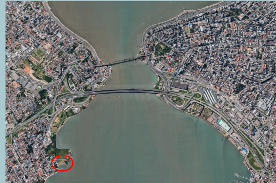
Espaço de ancoragem do Paraíso dos Cachorros Fonte: Geoprocessamento PMF – 2022
