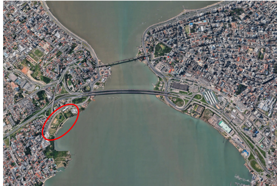
Espaço de ancoragem do Parque de Coqueiros e IFSC Fonte: Geoprocessamento PMF – 2022
