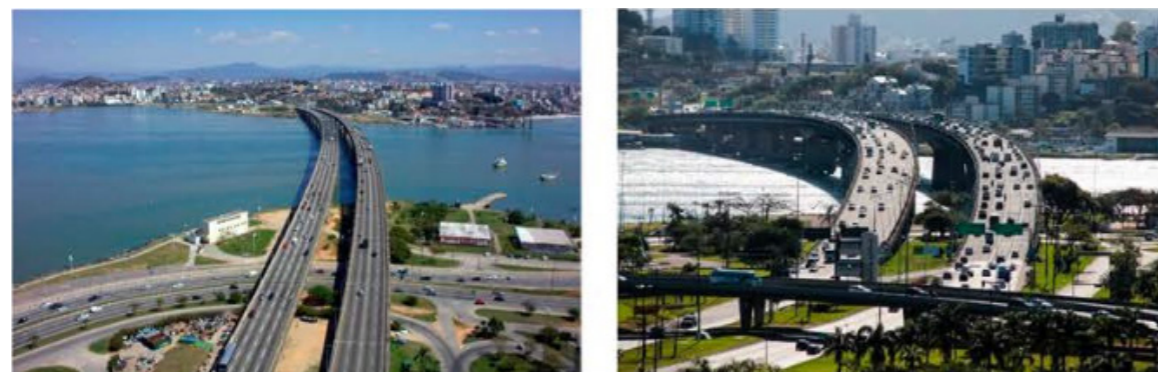
Espaço de ancoragem das cabeceiras das Pontes Pedro Ivo e Colombo Sales Fonte: NSC Total– 2021
