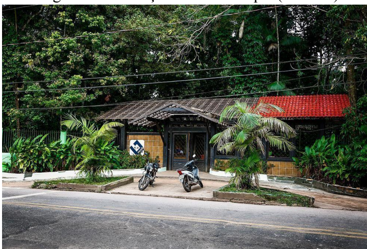
Figura 8 - Fundação Escola Bosque (Entrada)
