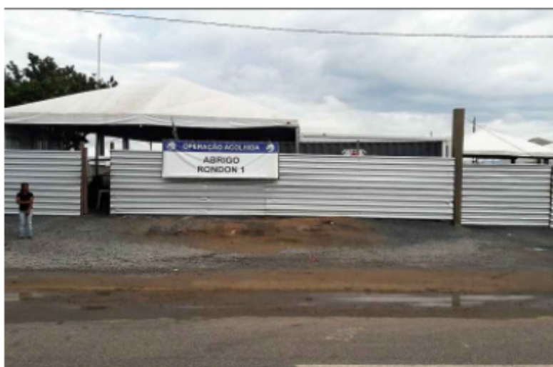
Figura 2: foto exemplo do muro de segurança. Fonte: Carbonari (2021).
