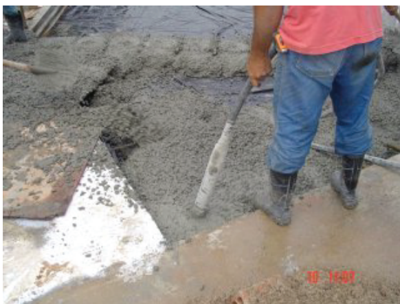
Uso do vibrador para adensamento do concreto
