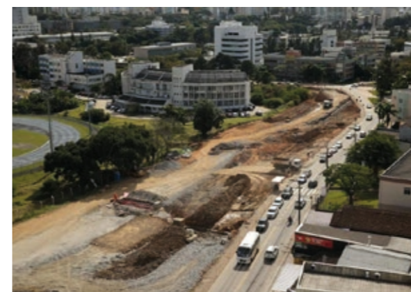
IMAGEM 60 - Edu Vieira em obras. FONTE: Gabriela Lain, 2019.
