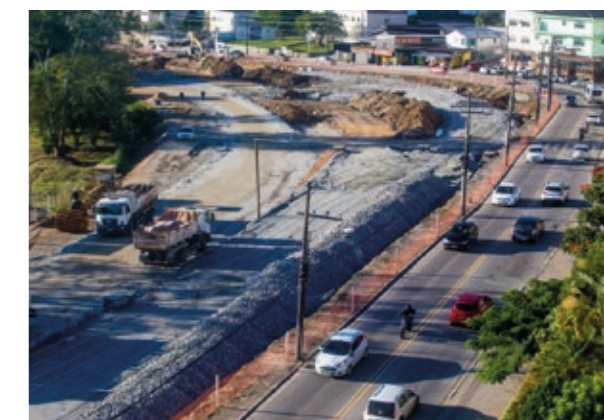
IMAGEM 61 - Edu Vieira em obras. FONTE: Flávio Tin, 2021.
