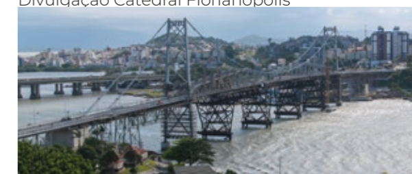
IMAGEM 69 - Ponte Hercílio Luz. FONTE: Julio Cavalheiro
