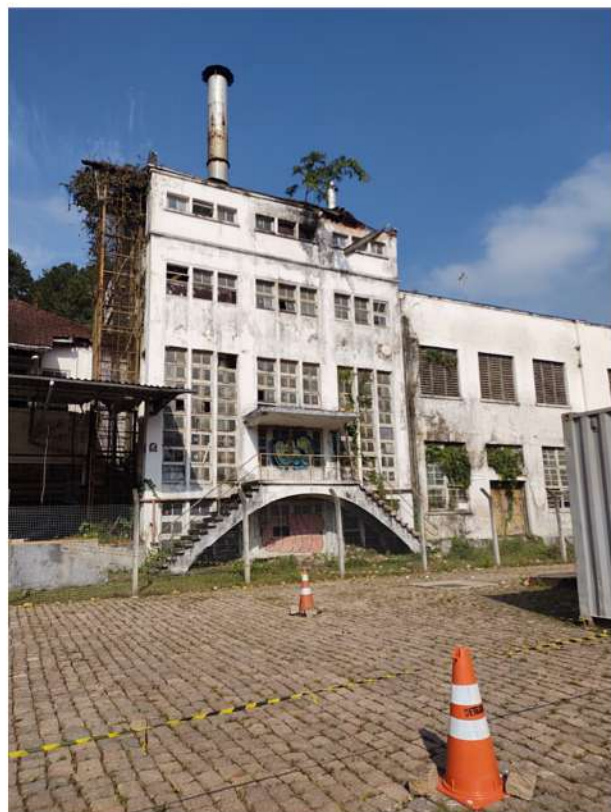
FIGURA 40. FOTOGRAFIA DO GALPÃO PRINCIPAL DA CIDADELA ONDE OCORRIA A FABRICAÇÃO DE CERVEJA. FONTE: ACERVO DA AUTORA.
