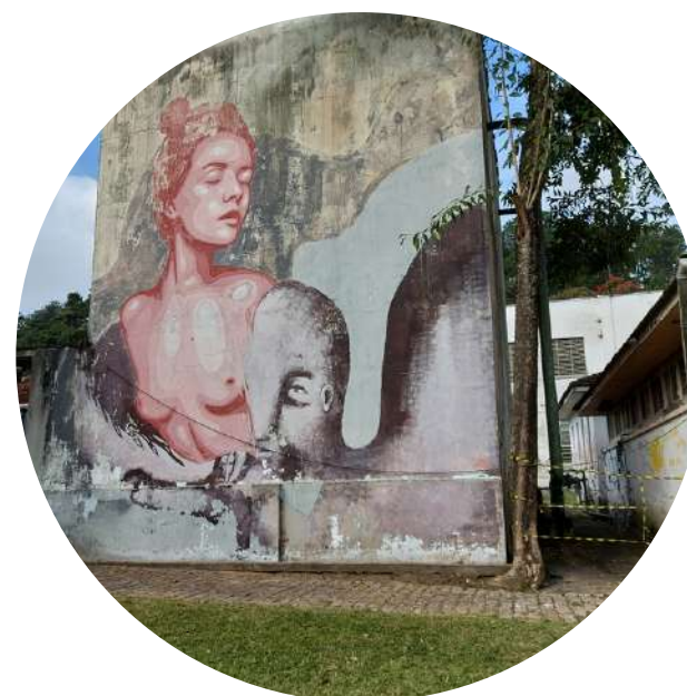
FIGURA 54. CAIXA D'ÁGUA. FONTE: AUTORIA PRÓPRIA.
