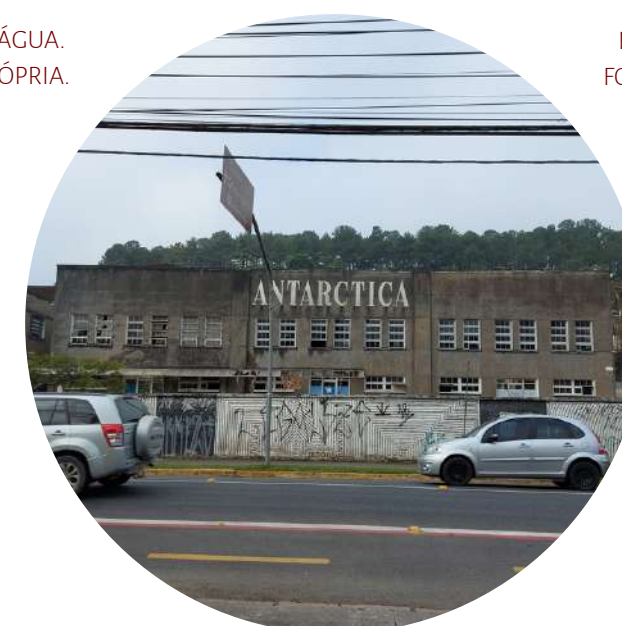
FIGURA 56. MURO EXISTENTE FONTE: AUTORIA PRÓPRIA.
