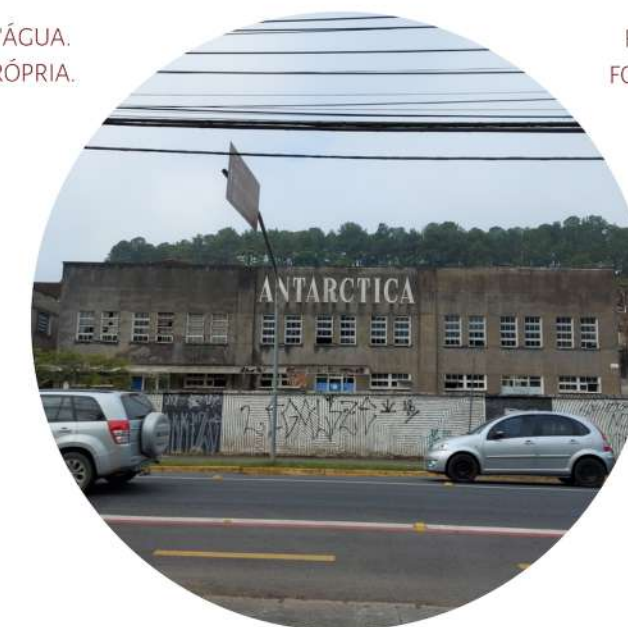
FIGURA 56. MURO EXISTENTE FONTE: AUTORIA PRÓPRIA.
