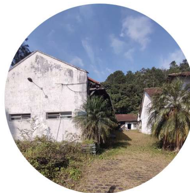
FIGURA 52. ANTIGA ESCOLA DE PANIFICAÇÃO. FONTE: AUTORIA PRÓPRIA.
