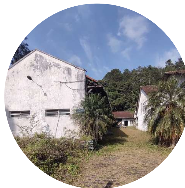
FIGURA 52. ANTIGA ESCOLA DE PANIFICAÇÃO. FONTE: AUTORIA PRÓPRIA.
