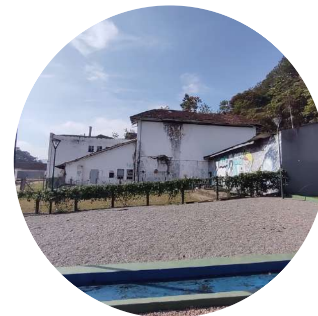
FIGURA 53. EDIFICAÇÕES ANEXADAS AO PRÉDIO PRINCIPAL FONTE: AUTORIA PRÓPRIA.
