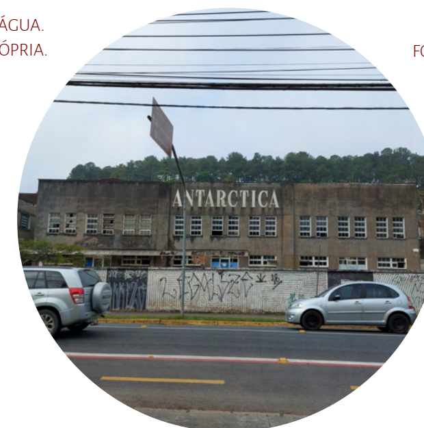
FIGURA 56. MURO EXISTENTE FONTE: AUTORIA PRÓPRIA.
