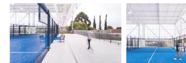
Figura 40: Áreas de convivência e quadra Fonte: Archdaily, 2021
