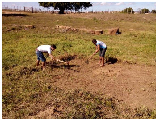
Figura 1: retirada de matéria orgânica. Fonte: elaborada pelos autores.
