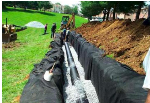
Figura 05: execução de uma trincheira de infiltração.
