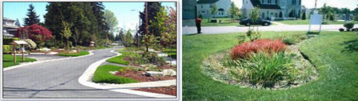
**Figura 2.** Foto da esquerda mostra rua em forma de onda e sem meio fio que permitem a infiltração de parte do escoamento nas laterais com vegetação. Na foto da direita é apresentada uma área de infiltração num canteiro. Fonte: Weinstein, (2003), apud Tucci, (2005)
