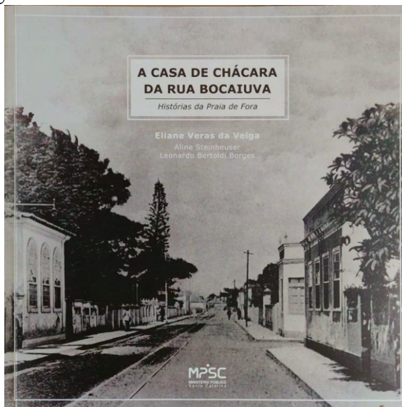
Figura 14 — “A casa de Chácara da rua Bocaiúva”
