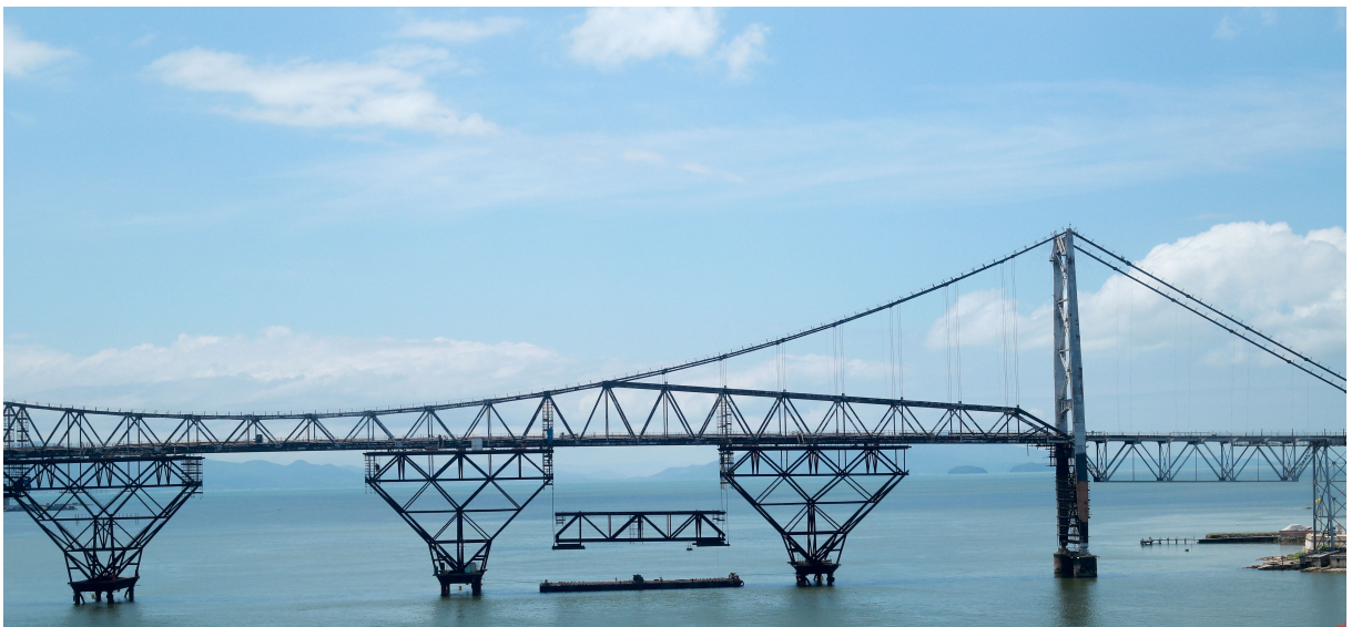
Figura 8 – Treliça da Ponte Hercílio Luz
