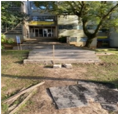
Imagem 5 – Ausência de condições adequadas para caminhabilidade
