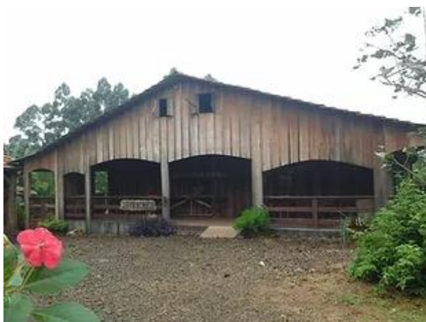
Figura 10: Fachada do Museu do Balseiro
