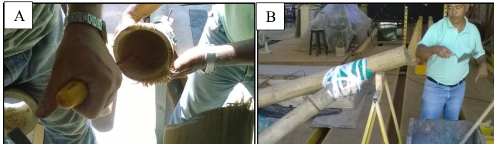
Figuras 5 – Retirada do diafragma do bambu e injeção de concreto. Fonte: autores.
