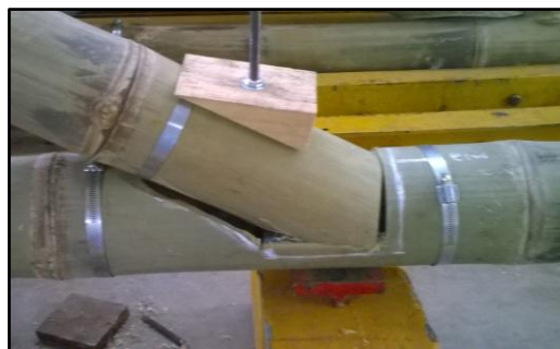
Figura 4 – Reforço com abraçadeiras. Fonte: autores.
