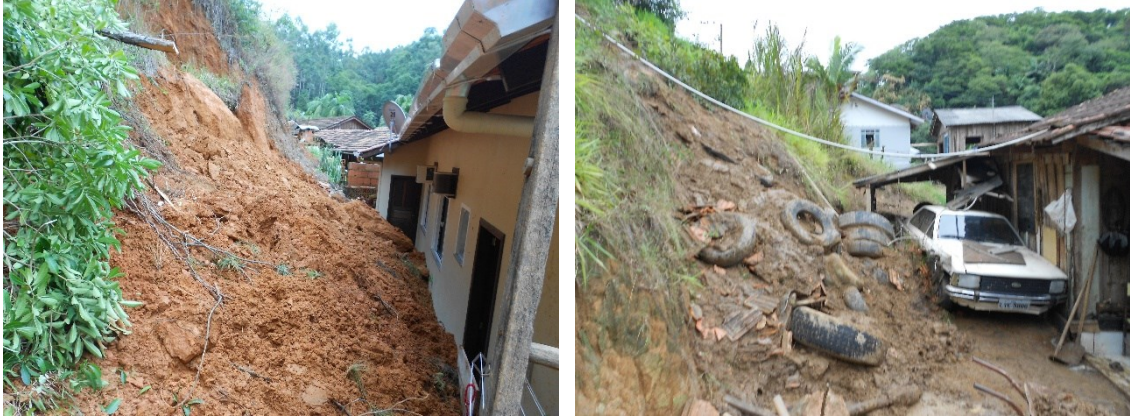
Figura 14 (a) (b) - deslizamentos ocorridos em 2014
