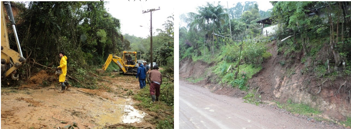
Figura 13 (a) (b) - deslizamentos ocorridos em 2013
