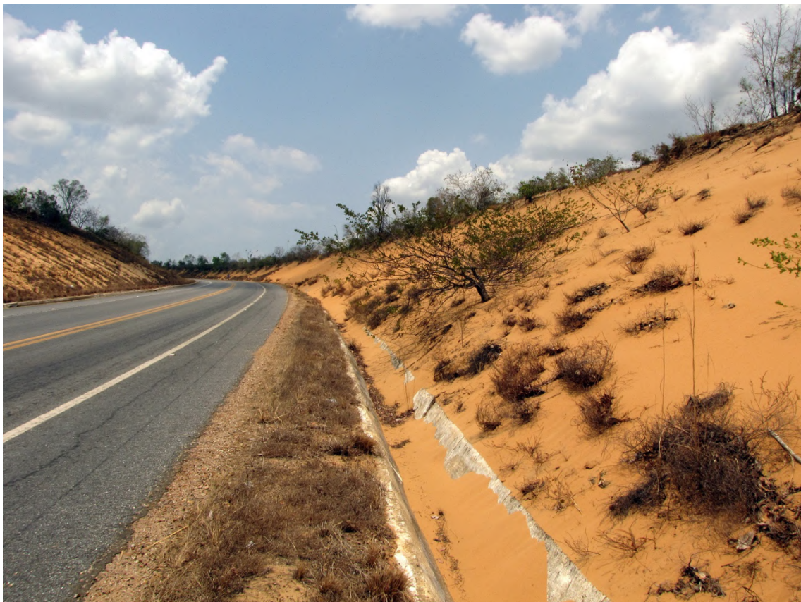
Figura 7.1: Vista de um dos perfis do depósito arenoso inconsolidado, aberto pela Rodovia TO-445, no entorno do sítio MT1. Fonte: Acervo do LEIA-UFSC.
