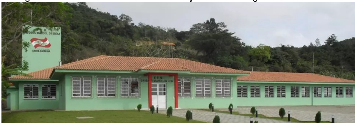
Figura 22 - Fachada da Escola de Educação Básica Gregório Manoel de Bem
