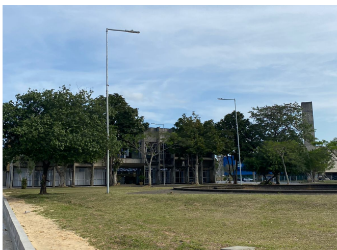
Figura 06: Fachada da Biblioteca Pública Municipal Donatila Borba.
