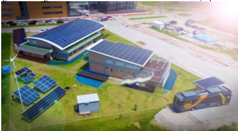
Figura 26: Energia Fotovoltaica UFSC – Laboratório Fotovoltaica (Sapiens Park)
