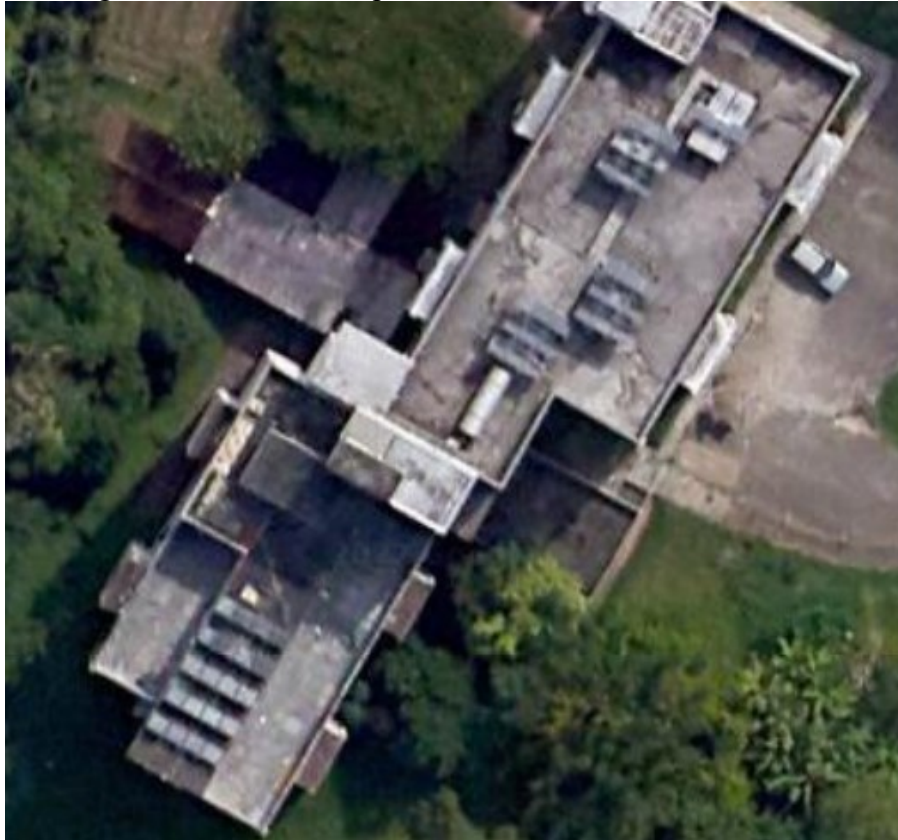
Figura 29: Painéis de aquecimento solar Moradia Estudantil
