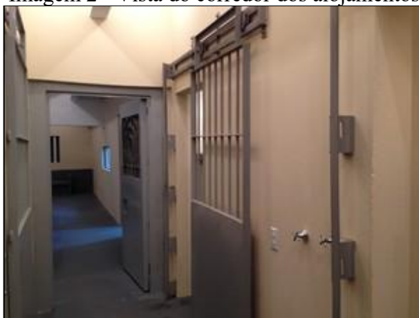
Imagem 2 - Vista do corredor dos alojamentos
