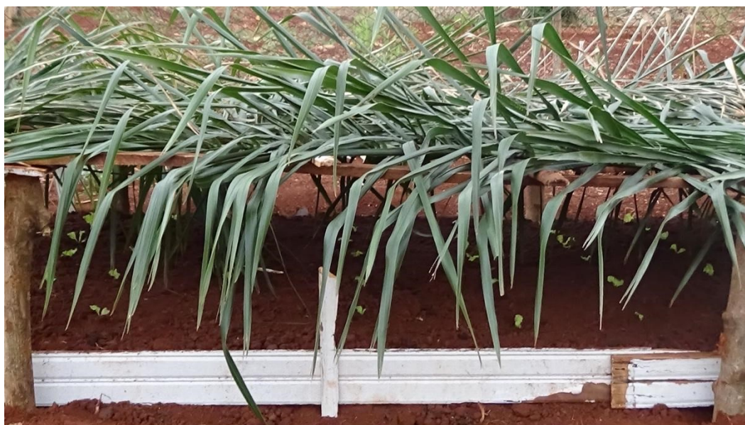
Figura 47 - Estrutura de proteção ao sol
