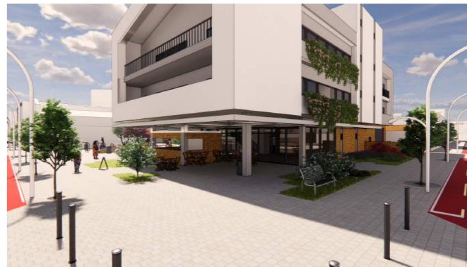
Vista da esquina.
