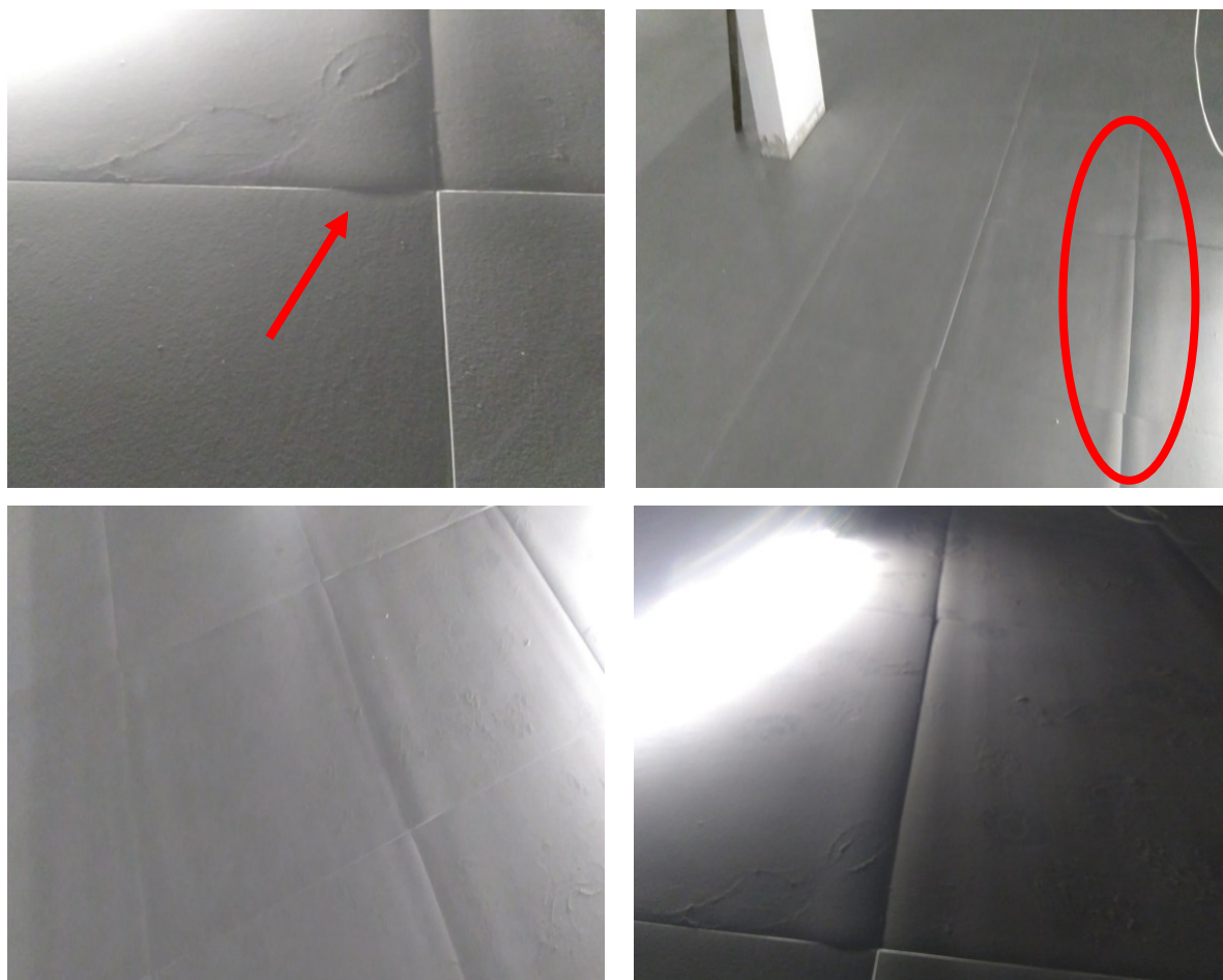
Figura 9 - Deformação das peças de porcelanato esmaltado ocasionados pela piropoplástica.
