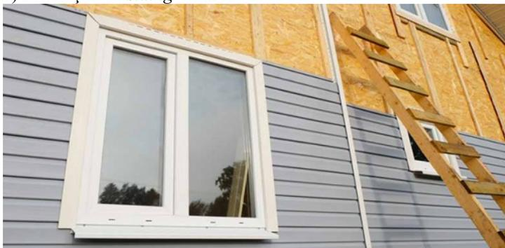
b) Placas construídas em PVC
