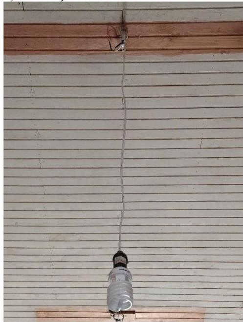
Outro ponto observado foi a presença de infiltrações no telhado evidenciado por marcas presentes no forro de madeira. Parte das manchas estão em contato direto com componentes da rede elétrica interna do edifício. Um exemplo é citado na Imagem 61 em que a fiação direcionada à iluminação de emergência está em contato com um ponto de umidade.
