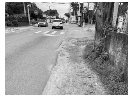
Figura 05 - Ausência de calçadas e acostamento Fonte: Arquivo Pessoal
