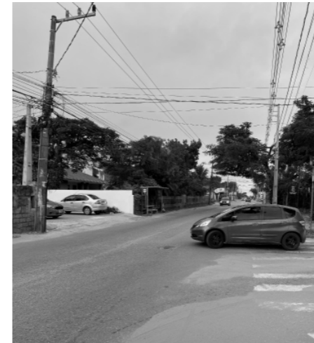
Figura 03 - Cruzamentos perigosos entre vias
