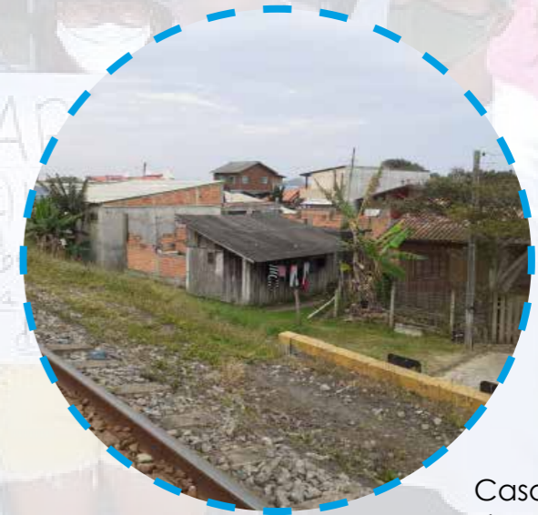
Construção em área de preservação
