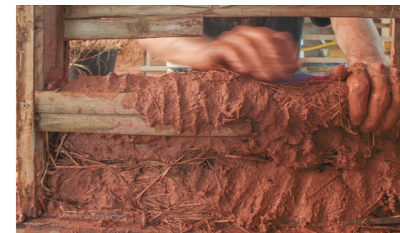
Mutirão para construção das paredes de bambu-a-pique da Casa Bambuzal (2022). Fonte: acervo da autora.
