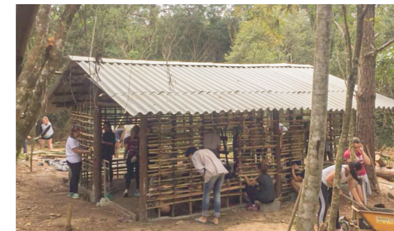
Mutirão para construção da casa de rezo na Aldeia Itaty (2018). Fonte: acervo da autora.
