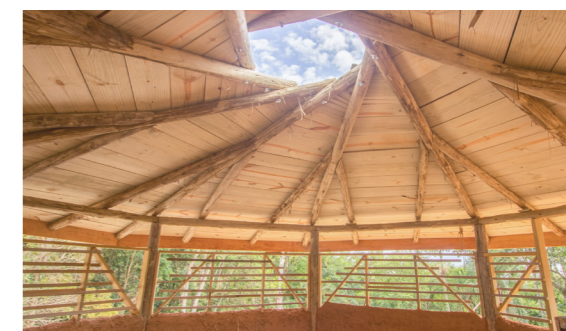
Projeto voluntário para construção do Espaço de Infância Guarani na Aldeia Yynn Moroti Wherá (2022 - 2023). Fonte: acervo da autora.
