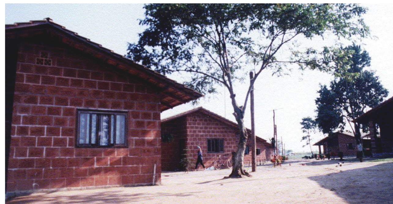
Moradias do Assentamento Rural Justino Draszevski. Fonte: Fárida Mirany de Mira (Disponível em: A Arquitetura no Assentamento Rural: Justino Draezelwisky, Araquari – SC, 2005).
