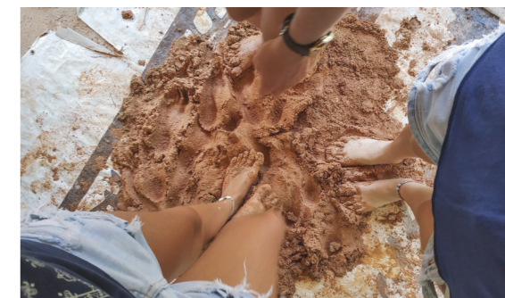
Mutirão para construção das paredes de pau-a-pique da Escola Anamayé (2019). Fonte: acervo da autora.
