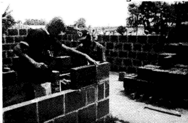
TRABALHADORES CONSTRUÊM AS CASAS DO ASSENTAMENTO JUSTINO DRASZEVSKI
