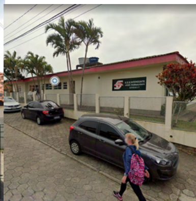
Anexo I - Rua Dário Manoel Cardoso
