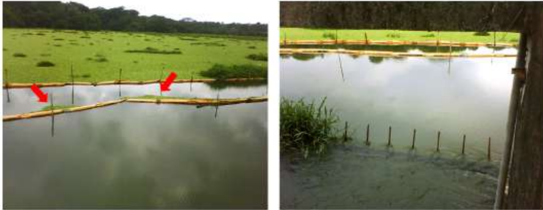
Figura 4 - Sistema de proteção da estação elevatória do Lago Bolonha em três telas; setas indicam presença de Eichhornia crassipes Solms na tela intermediária.
