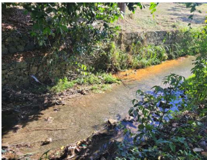
Figura 15 - Início da utilização de alvenaria em Pedra no Rio do Meio
