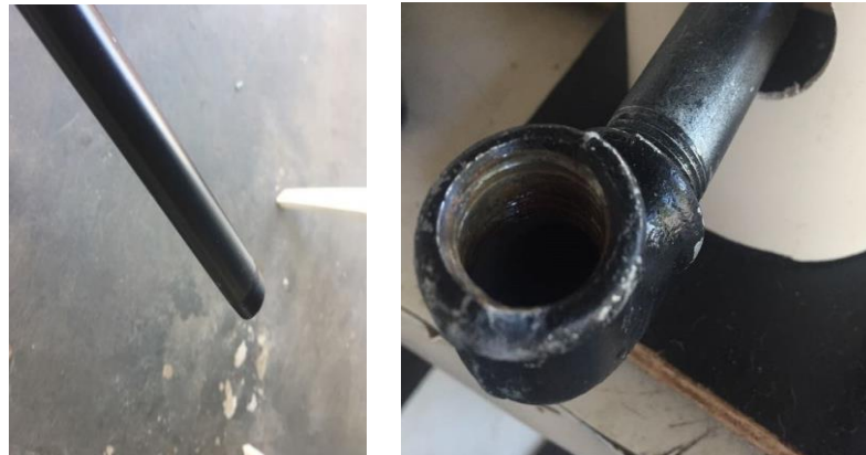
Figura 6: (a) Tubulação central. (b) Conexão rosqueada. Fonte: elaborado pelo autor.
