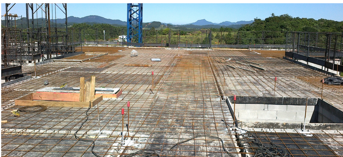
Figura 5: Formas para concretagem in loco . Fonte: cedida pela construtora (2018).
