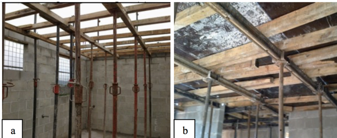
Figura 2: Escoramento da laje moldada no local (a) e formas de madeira posicionadas para concretagem (b). Fonte: cedida pela construtora (2014).
