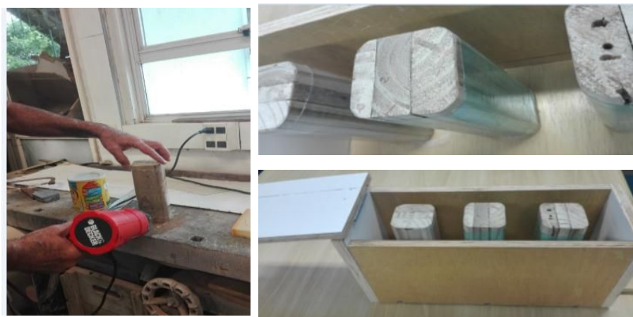
Figuras 11, 12, e 13 preparação e construção da forma para o bloco Fonte: autoral
