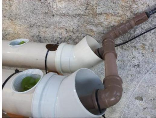
*Figura 13 - ENTRADA DE ÁGUA NO SISTEMA HIDROPÔNICO*
