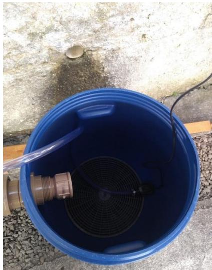
*Figura 12 - DETALHE DO ESTOQUE DE ÁGUA E BOMBA SUBMERSA*
