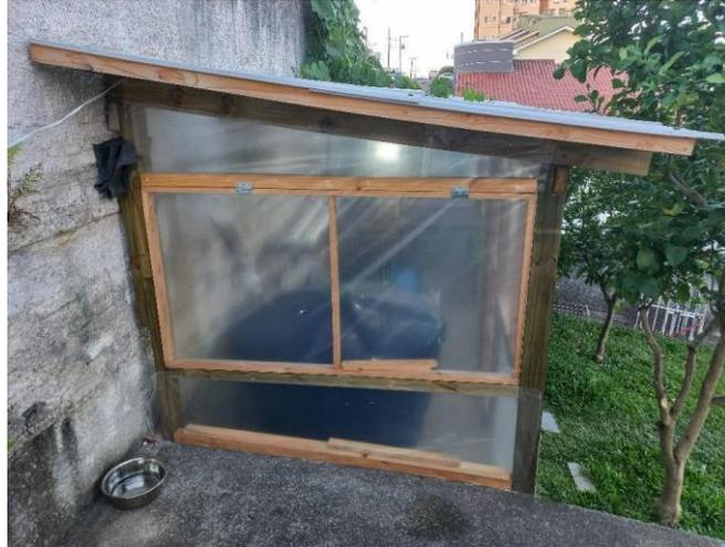
*Figura 6 - FECHAMENTO DA ESTRUTURA COM PLÁSTICO PARA ESTUFA*
