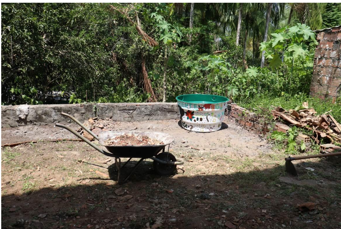
Fig. 16: Terreno limpo e caixa d'água no local escolhido
