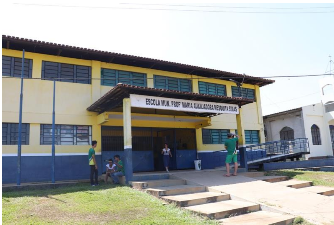
Fig. 1: Fachada da escola
