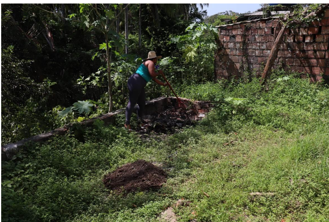
Fig. 6: Terreno antes da limpeza
