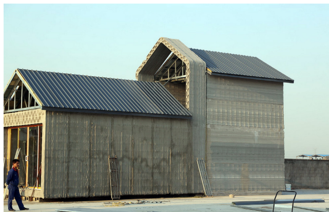
Figura 03 - Casa construída pela Winsun
