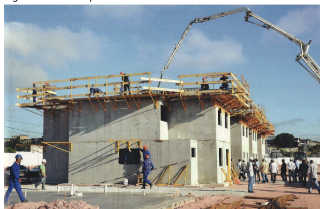
Figura 05: Paredes pré-moldadas em concreto
